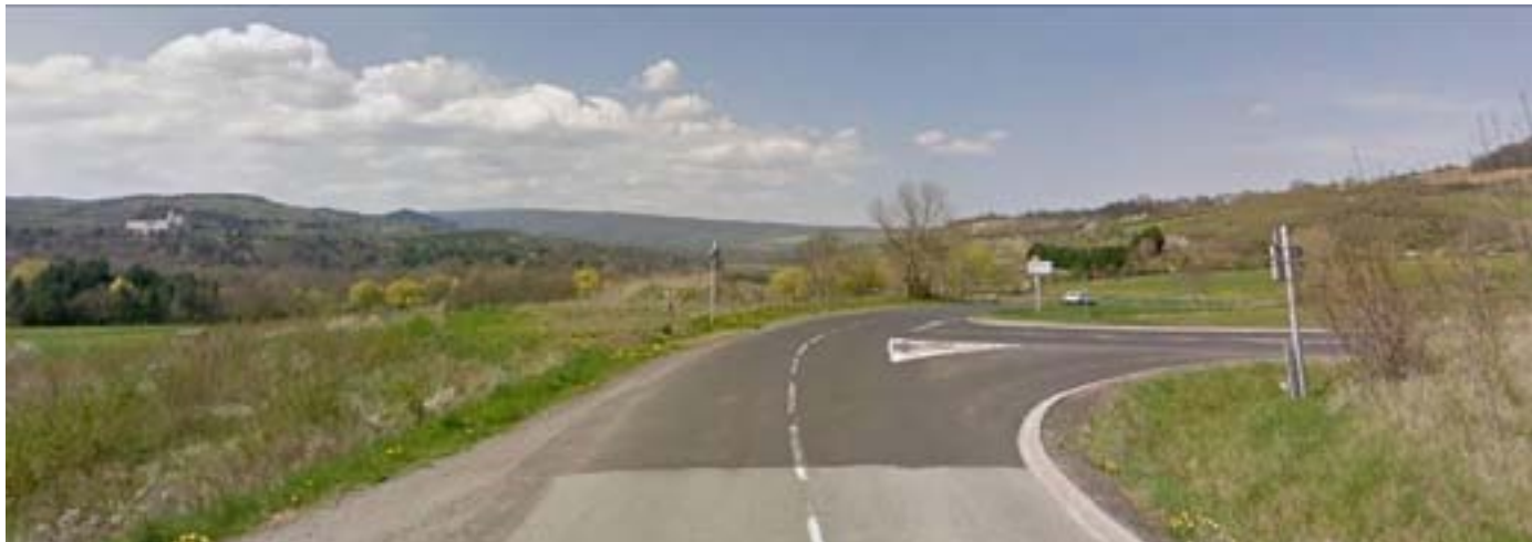
La RD28 à la hauteur de son intersection avec la RD74
