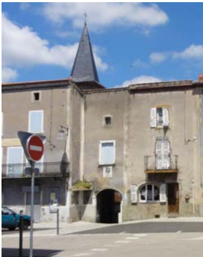
Passage couvert, porche permettant d'entrer dans la partie médiévale du fort
