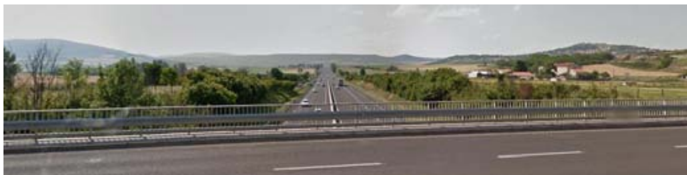
L'A75 à la hauteur de l'échangeur autoroutier n°6 permettant l'accès aisé à Saint-Sandoux
