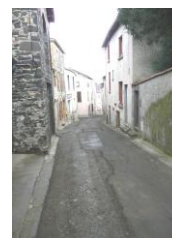
Travaux en cours Rue du Commerce
