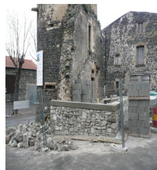
La Tour des Forts en cours de restauration
